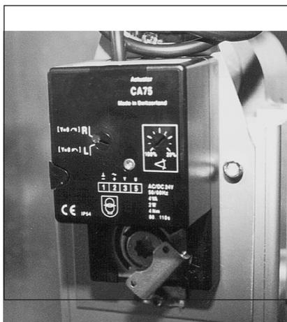
Corpo dell'attuatore in plastica, **senza funzione di emergenza**, con angolo di rotazione limitato elettronicamente a 90°, adatto esclusivamente per il collegamento diretto con le unità di connessione **Esco 5** ed **Esco 10**. **Ideale se utilizzato in combinazione con umidificatori a bassa capacità per incrementarne il livello di umidificazione.**
